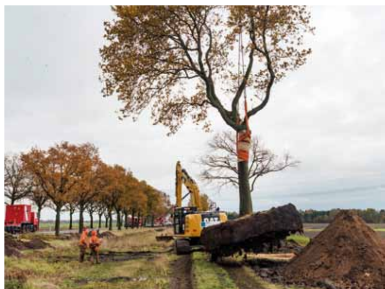
Hoofd uitvoering Jan Koelstra: 'Zo'n groot aantal bomen verplanten, dat gebeurt niet dagelijks. En dat met drie verschillende verplantmethodes: met een kleine verplantmachine, een grote verplantmachine en een telekraan.' (©BTL Nederland)
