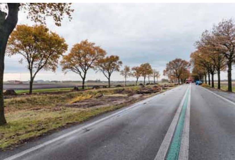
Alle 129 zomereiken staan nu enkele meters verderop in de berm.
