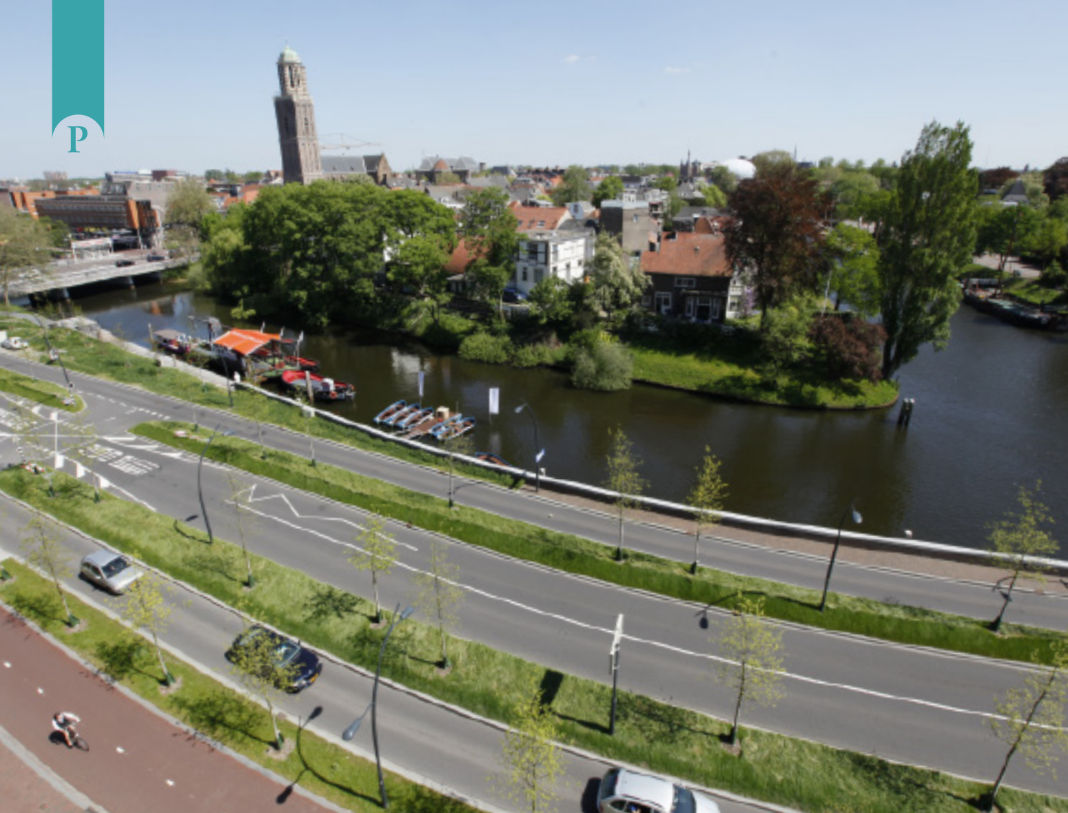
De Pannekoekendijk-Harm Smeengekade is dé hoofdree naar het centrum van Zwolle vanaf de A28. Slim ontwerp zorgde voor een parkachtige omgeving.
