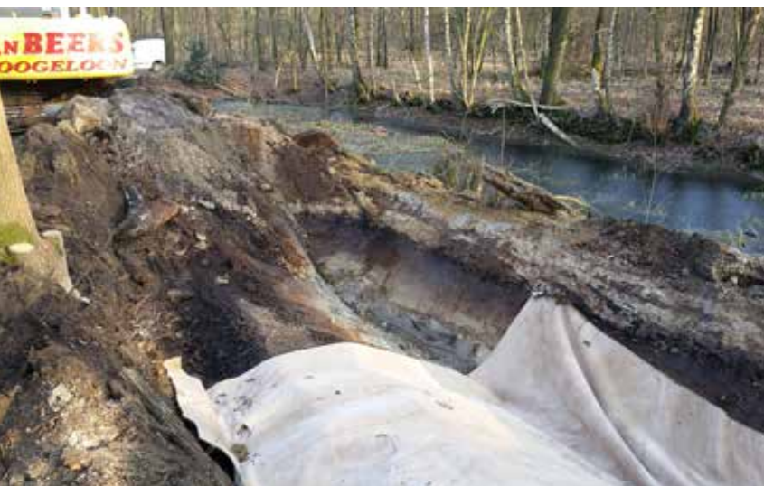
Bentoniet aanbrengen.
