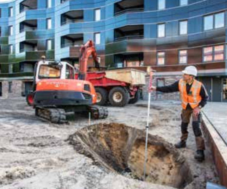
Start aanleg rain garden
