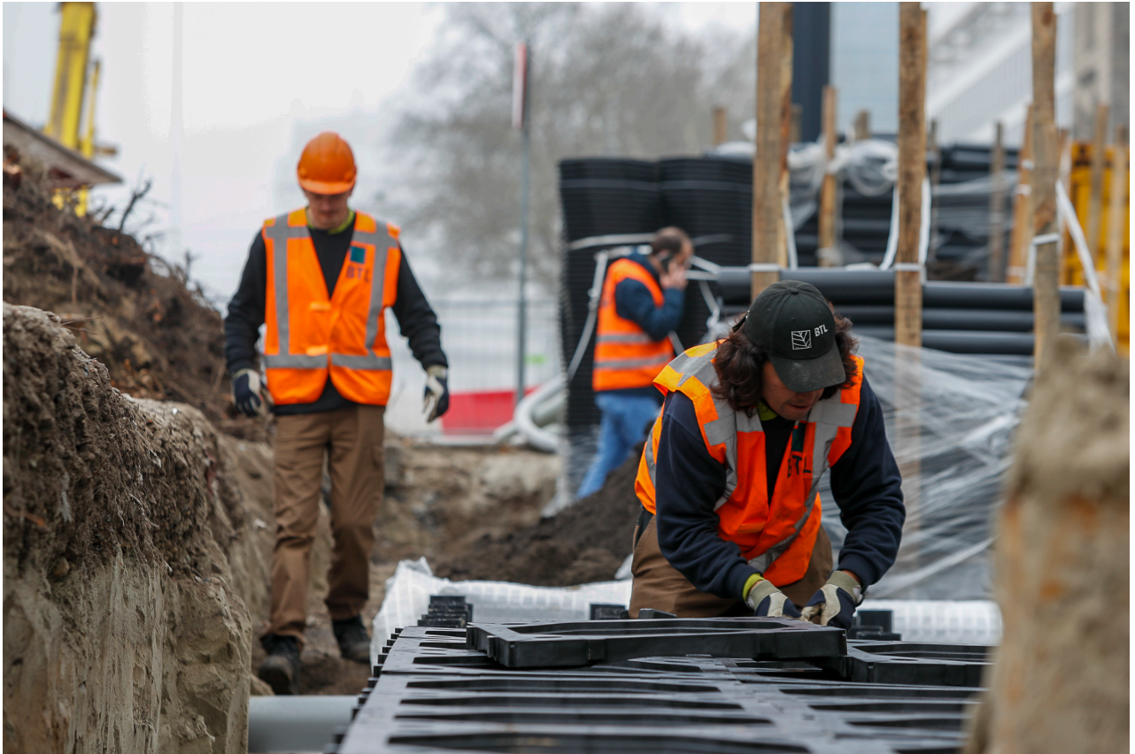
Het specifieke 'groene' werk, de bouw van de TreeParkers, is door hoofdaannemer Van Gelder uitbesteed aan BTL Realisatie bv, in samenwerking met BTL Bomendienst. (Foto: Adriaan van Dam)
