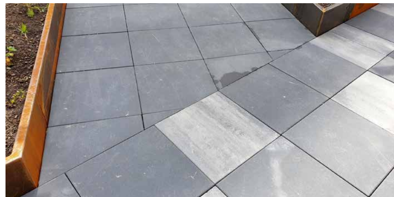
De verharding bestaat uit 60 x 60 cm betontegels in een grijze en antracietkleur.
