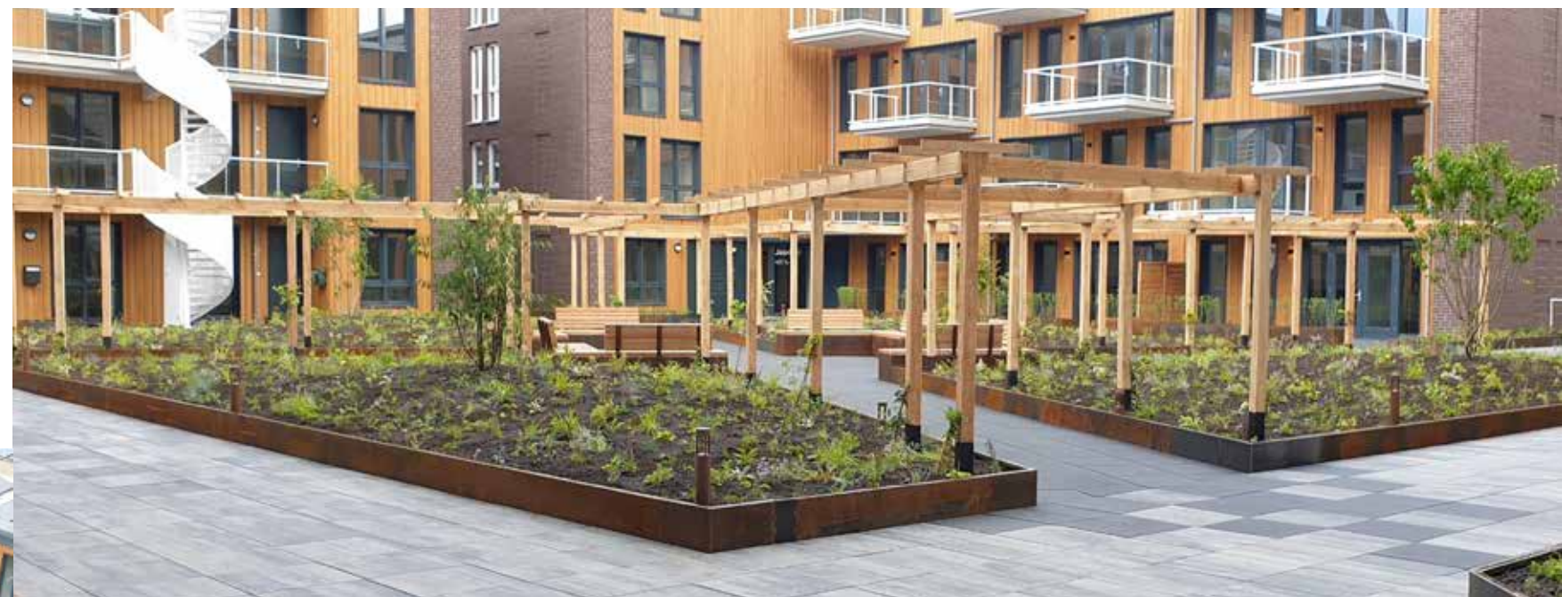
Er is een grote pergolaconstructie van ca. 60 meter langs de tegelpaden geplaatst.
