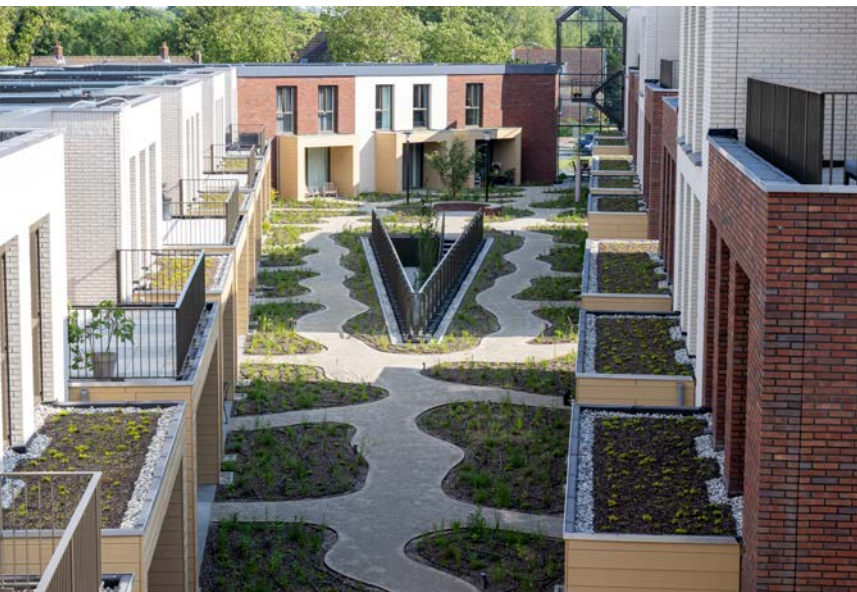
Aanleg van een groendak op de Wervenkade in Dordrecht. Een groendak draagt bij aan een beter klimaat, vergroot de biodiversiteit en verlaagt de ecologische voetsporen.
