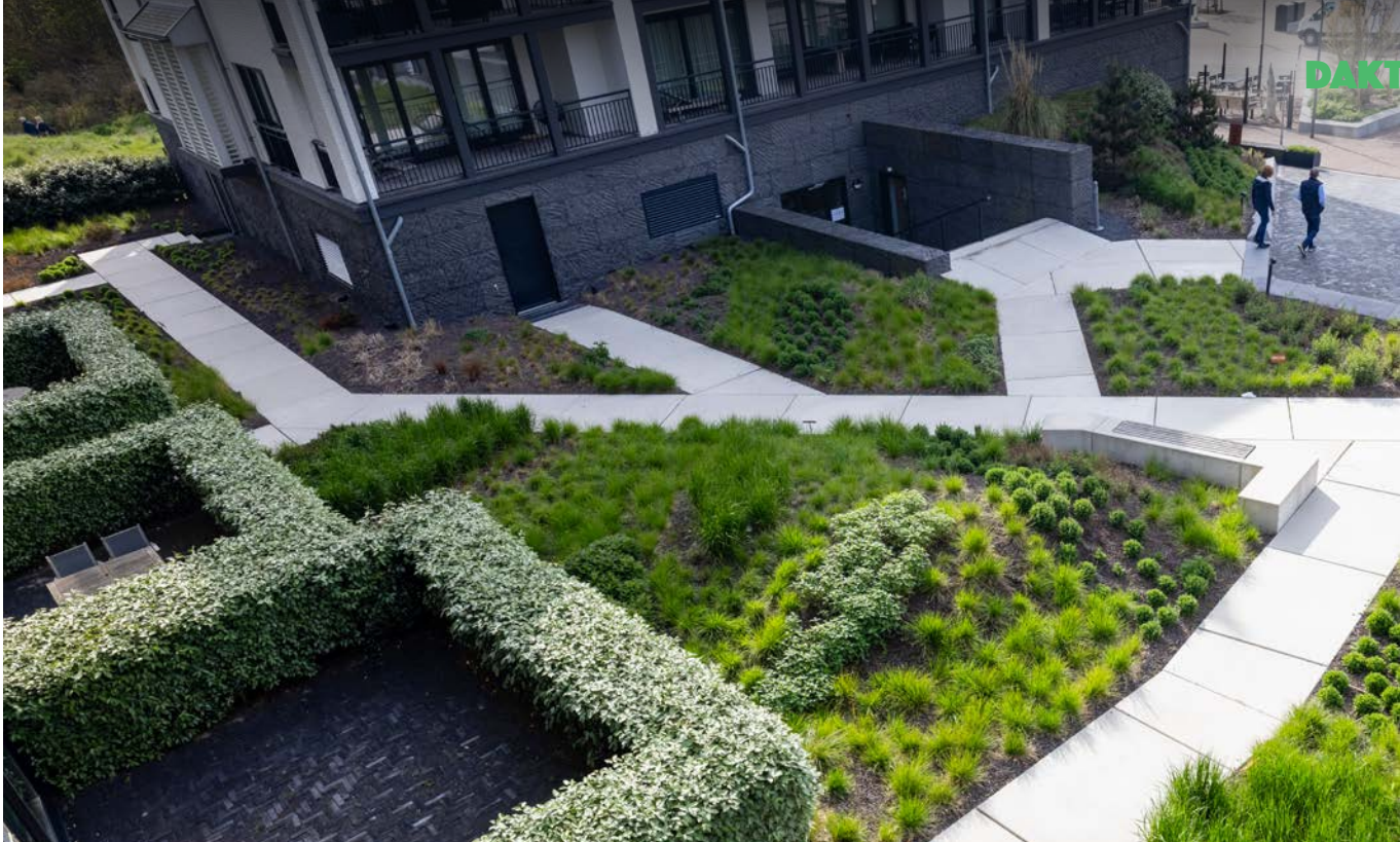
Daktuin aangelegd door idverde bij Strandhotel in Cadzand-Bad.
