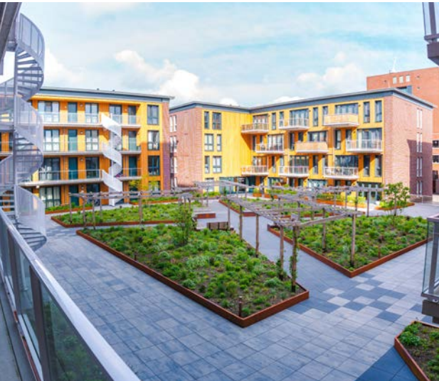
Daktuin aangelegd door idverde bij het wooncomplex Goudshof in Gouda.
