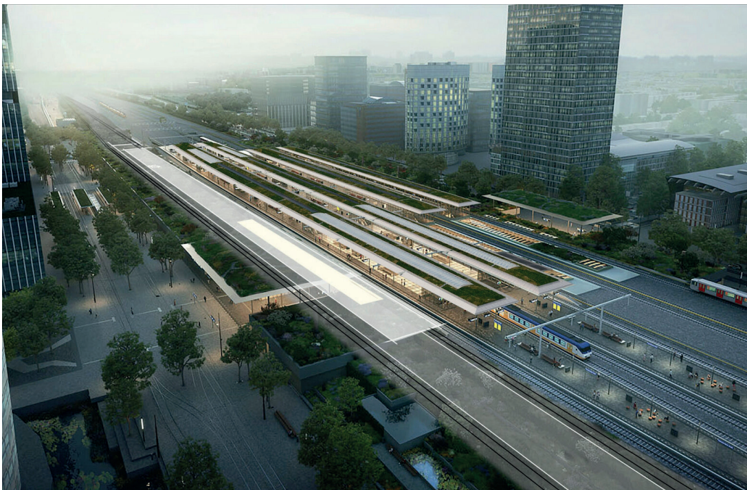
De nieuwe perronkappen van station Amsterdam-Zuid worden voorzien van groendaken.
